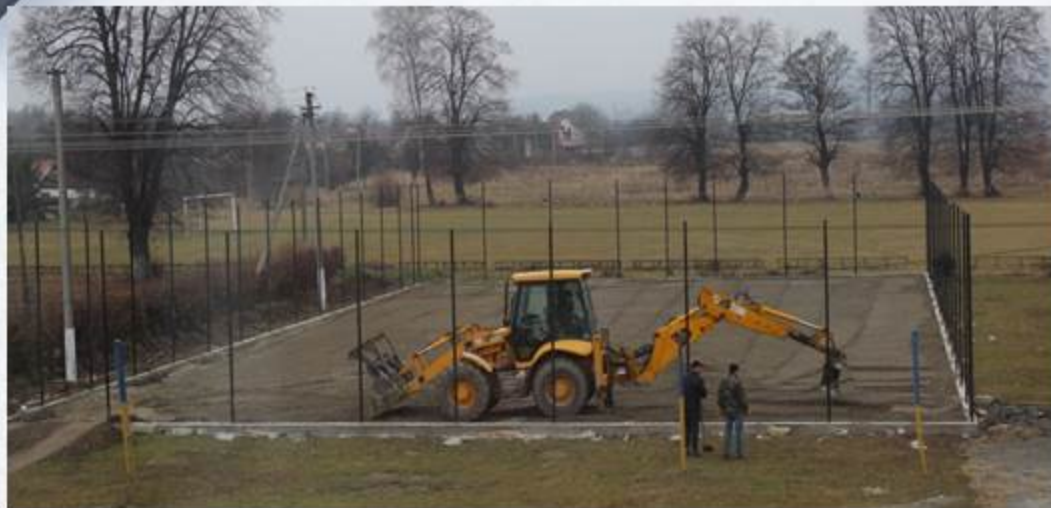
Будівництво спортивного майданчика із штучним покриттям
