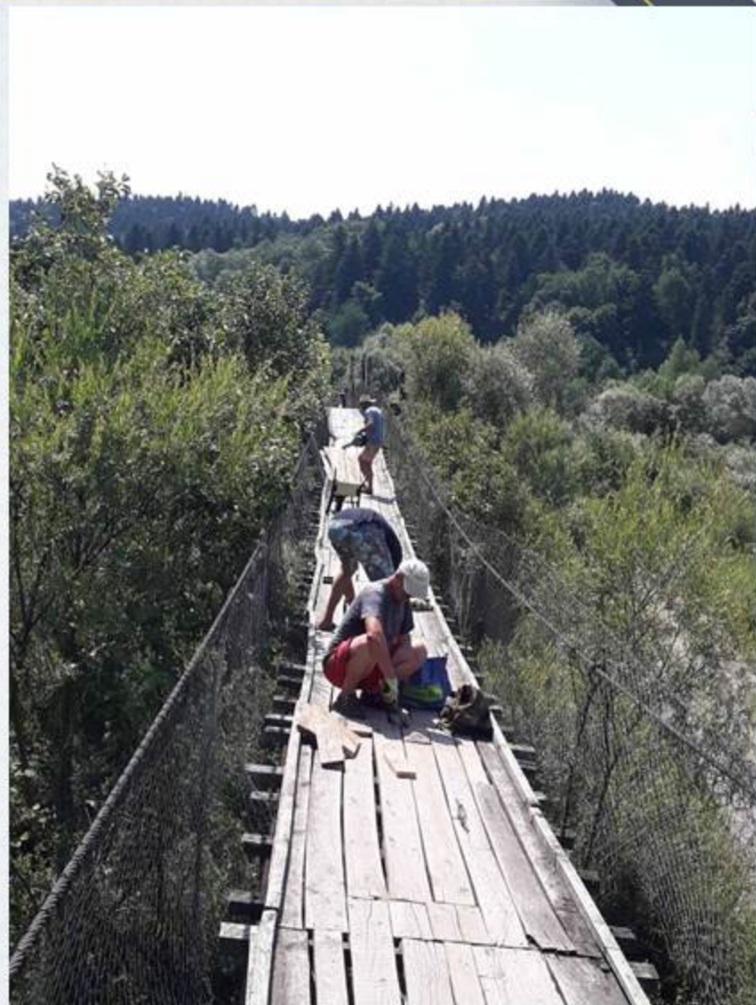
Ремонт підвісної лавки через річку Прут
