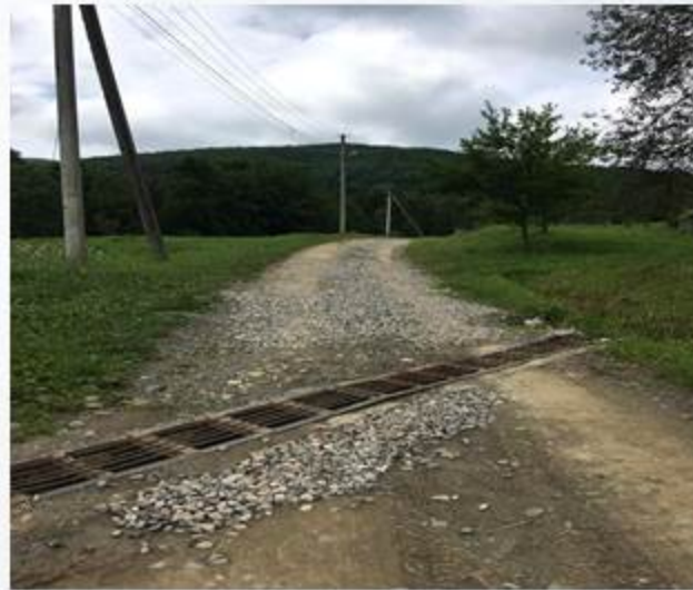
Встановлення водовідведення на комунальних дорогах
